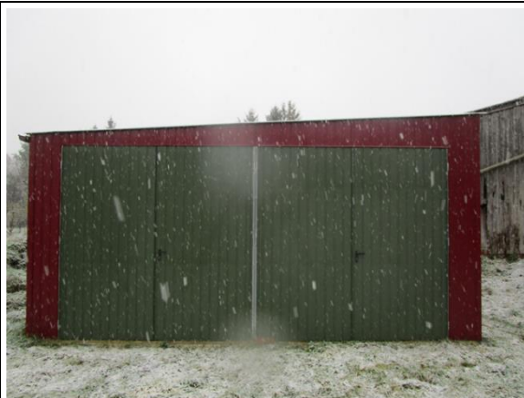
Abbildung 7 Hinteres Nebengebäude ausgehend von der Blickrichtung aus Westen auf das Flurstück 45
