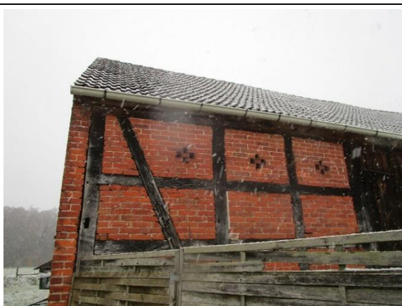
Abbildung 9 Vorderes Nebengebäude ausgehend von der Lindenstr. auf das Flurstück 49,
