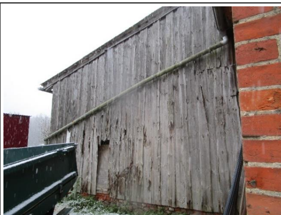
Abbildung 10 Hinteres Nebengebäude ausgehend von Blickrichtung aus Westen auf das Flurstück 49
